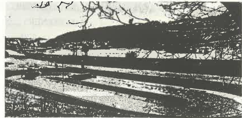
نگاره ۸- گودالهای اکسیدی کردن (ساخت کارخانه‌ی پاساوان - میشل باخرهوتنه)
